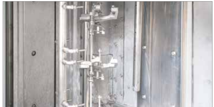
Vista de la zona de secado: Secado con sistema rotatorio de boquillas y potente compresor de canal lateral
